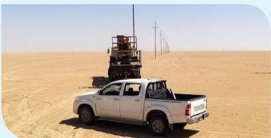
باشرت يوم الخميس الماضي وحدة الكهرباء بمنطقة الصيانة حقل النافورة، مرحلة تركيب الشادات والعارض الحديدي 5 والعوازل، وسحب الأسلاك الكهربائية لـ 5 آبار بمنطقة النافورة - أوجلة، بعد الانتهاء من مرحلة الحفر وتشييت الأعمدة.
